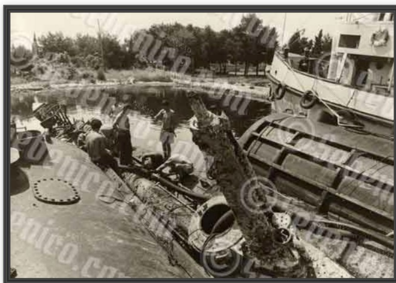
Nereide u uvali Škar gdje je bila dotečljena na cilindrima sa kojima je podignuta sa dna podno Palagruže. U prvoj etapi je podignuta na dubinu od dvanaest metara i odtečljena je sa Palagruže do uvale luke Rogac na Šolti. Tamo je prvi put pregledana unutrašnjost.
